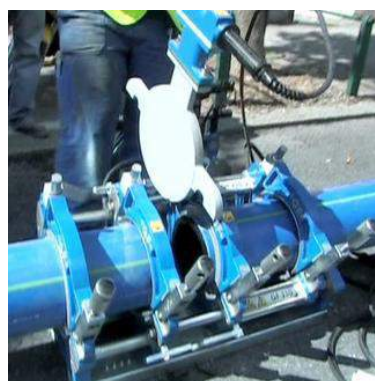
Image 16 : Soudage d'une canalisation PE équipée d'une membrane de protection extérieure en PP pour le remplacement d'une canalisation par cracking [25]
