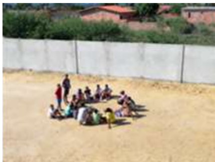
Erhöhung der Mauer
