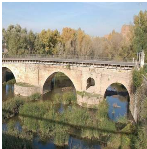
Detalle de un arco de herradura en el puente del Henares
