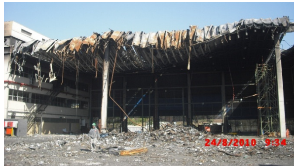
Figura 7. Estrutura deformada na forma de catenária.
